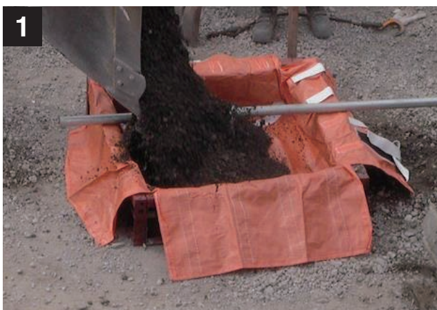
D・BOXを専用型枠にセットし、上部より中詰材料を投入
