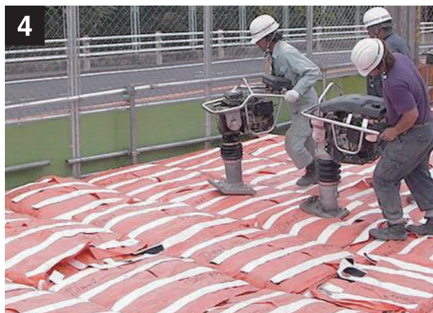
敷設が完了したら、ランマーを使い転圧
