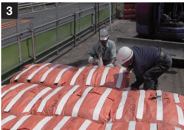
重機やクレーンで吊上げ敷設箇所に設置
